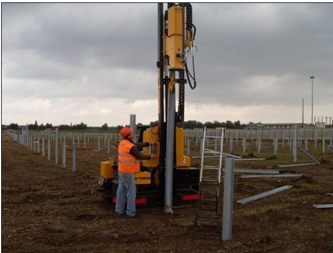
Fot. 6. Montaż profili za pomocą kłafara (fotografia z zasobów inwestora).
